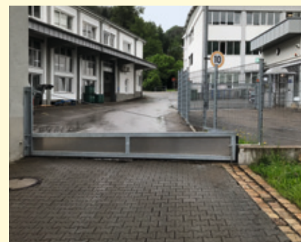
Umleitungsschott zum Schutz des Hauptwerks vor Überflutungen
