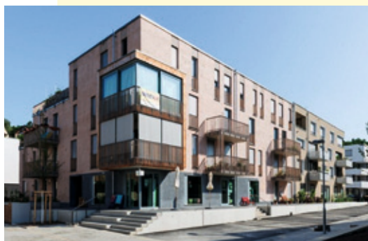
Erhöhte Vorzonen schützen die Gebäude bei Hochwasser.
