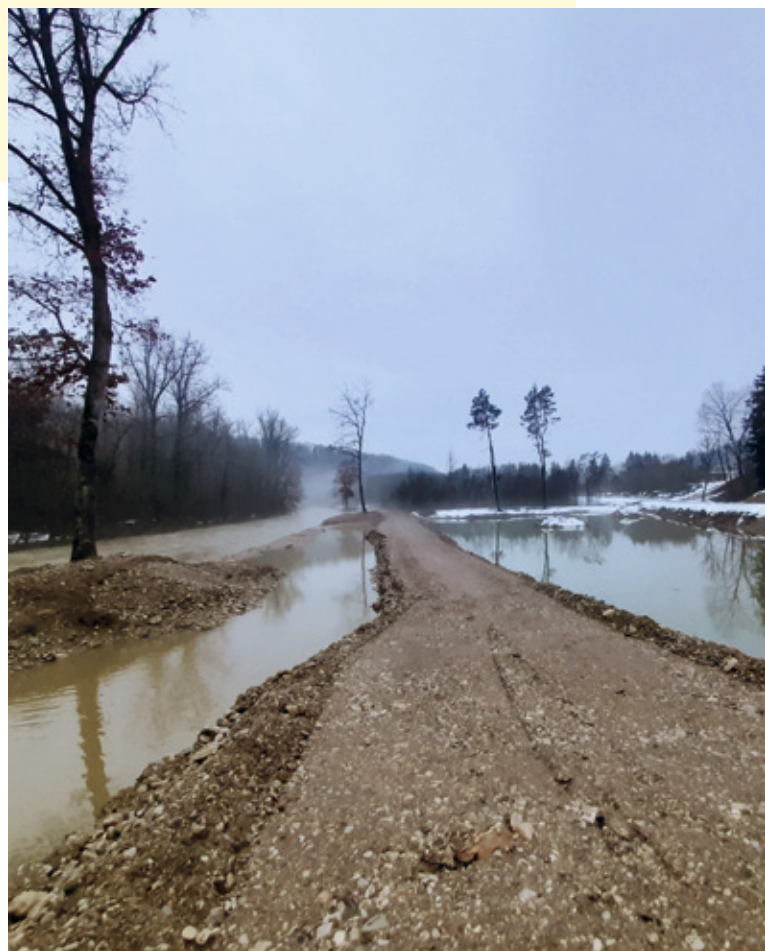
Die Renaturierungsfläche bei Stühlingen im Bauzustand: Das Hochwasser Ende Februar 2021 durfte die Fläche schon vor Fertigstellung in Besitz nehmen.
