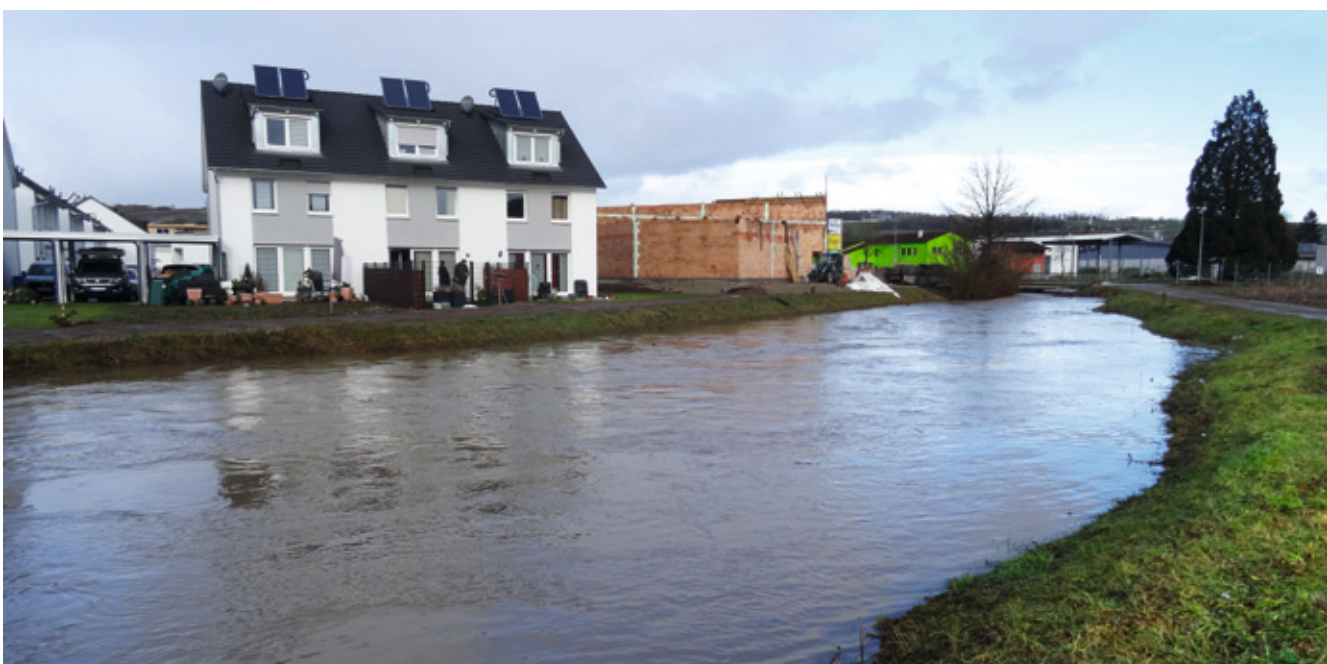
Hochwasser des Klingengrabens bei Erzingen
