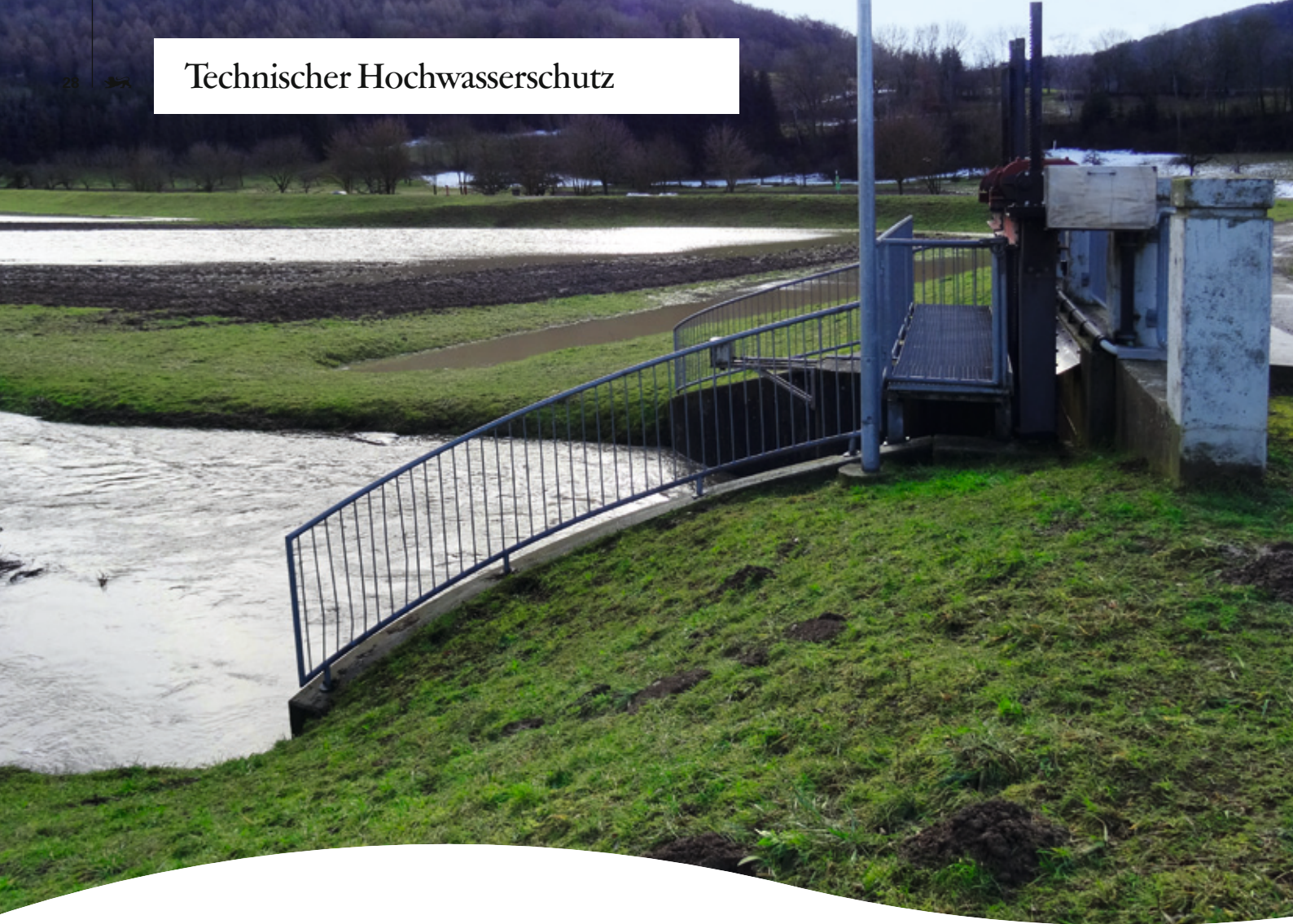
Absperrbauwerk des Hochwasserrückhalte- beckens am Schwarz- bach bei Grießen im Klettgau
