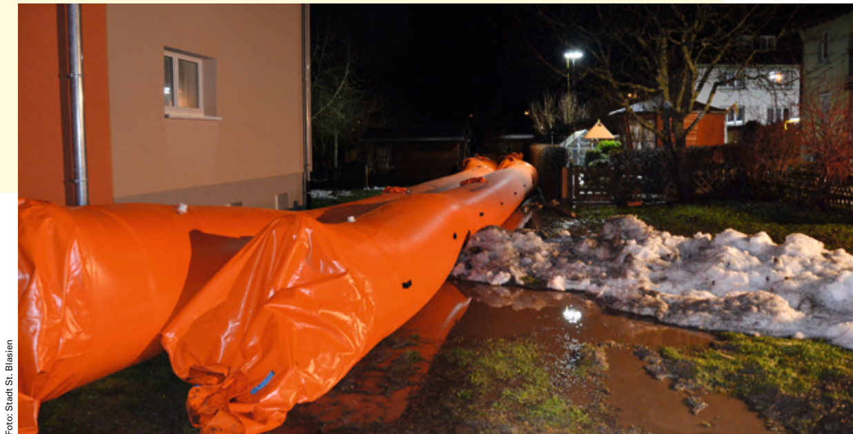
Aufbau eines mobilen Hochwasserschutz- damms in Sankt Blasien
