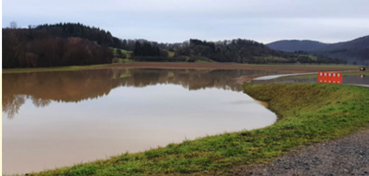
Hochwassereinstau im Hochwasserrück- haltebecken Griesen im Frühjahr 2021
