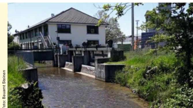
Der Bypass entlastet den Gewerbekanal bei Hochwasser.
