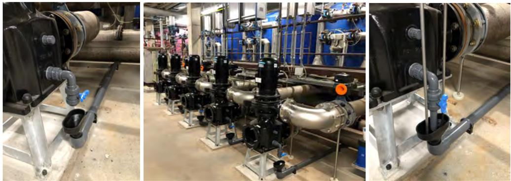
Endleerung- und Endlüftungsleitung Abführung in die Ablaufrinne der Hebeanlage
