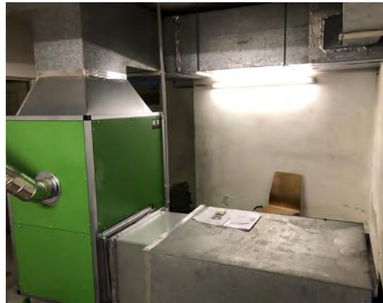
Eingebaut wurde ein Luftheritzer von REMKO Baujahr 2020 mit einer Nennwärmebelastung von 54 kW.
