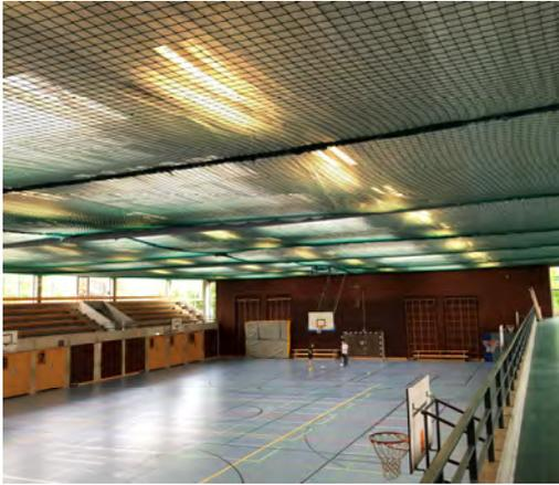
Durch das immer wieder undichte Hallendach ist die abgehängte Decke instabile geworden. Leider konnte die in den letzten Jahren im Haushalt vorgesehene Sanierung des Hallendaches aus verschiedenen Gründen bis heute nicht umgesetzt werden.
