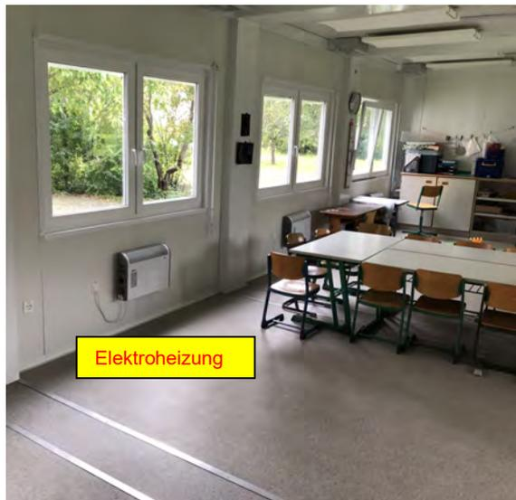
Der Wärmeschutz der Container entspricht der aktuellen EnEV. Allerdings entsteht bedingt durch die Konstruktion der Bauteile ein recht schwieriges Behaglichkeitsempfinden. Erschwerend kommt hinzu, dass durch die Hygiene-Lüftung und durch die Infrastruktur (Toiletten, Kopierer, Lehrerzimmer im nebenstehenden Hauptgebäude) ständig kalte Luft nachströmt. Dadurch kommt es vermehrt zu Zugscheinungen und Wärmeverlusten.
