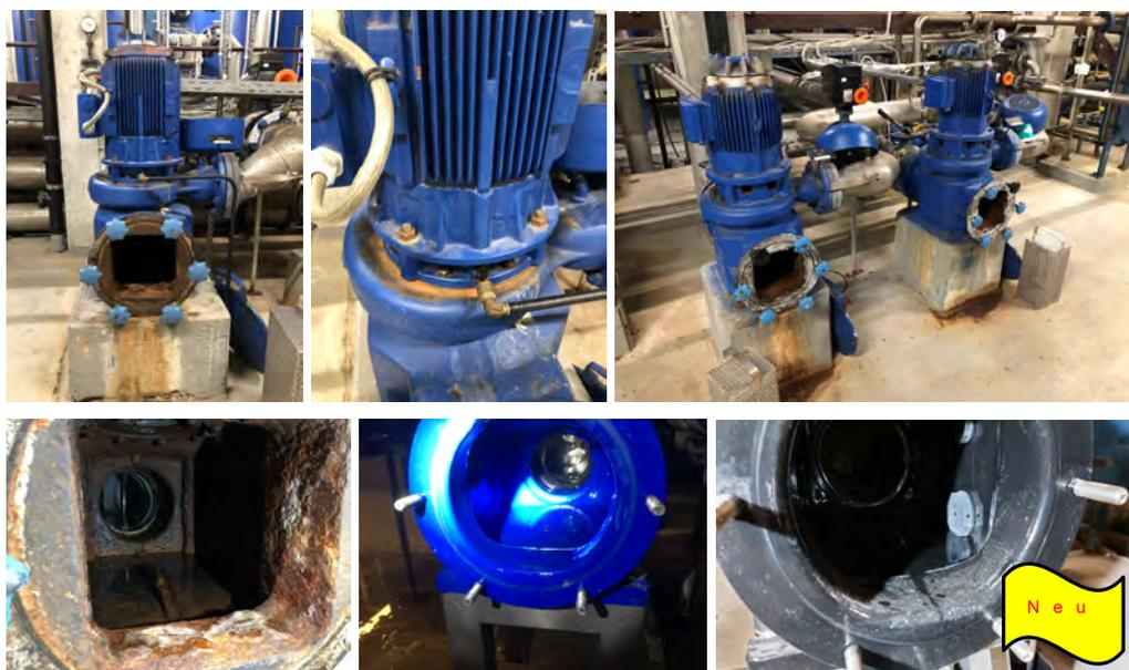
„alte“ Herborner Pumpe: Grauguss-Beschichtung oxidiert
