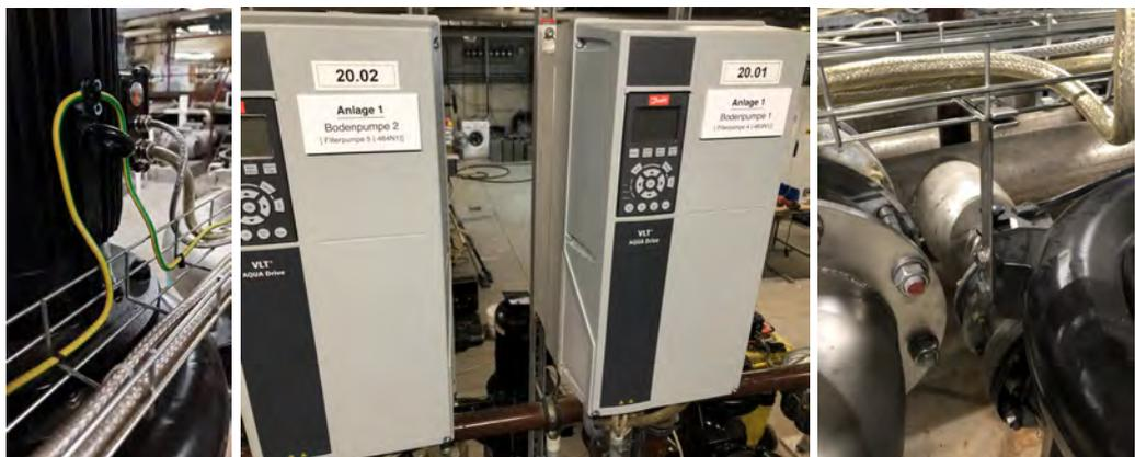
Elektrischer Anschluss der Maschinen (Erdungskabel, Frequenzumrichter, Edelstahl-Kabelkanal)
