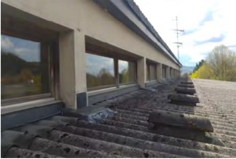
**IST-Zustand:** Das versetzte Pultdach, welches die oberen Räume direkt abgrenzt, ist getragen von T-Trägern aus Furnierholz mit einem Abstand von 170 cm. Zwischen den Träger ist eine 8 cm starke Dämmschicht aus Mineralwolle einge-
