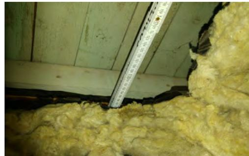
Der theoretische Wärmedurchgangskoeffizient (U-Wert) dieser Konstruktion lag bei ca. 0,43 W/m<sup>2</sup>a. Allerdings wurden bei der Berechnung die Ritzen und Fugen der Konstruktion nicht berücksichtigt, so dass der reale Wärmeschutz als deutlich schlechter eingestuft werden musste.
