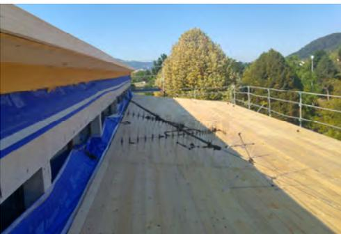
**Dachsanierung:** Auf Grund der Dachkonstruktion konnte nur eine zusätzliche Aufdachdämmung umgesetzt werden. Hierfür wurden die asbesthaltigen Eternitplatten fachgerecht entfernt und entsorgt. Ebenso wurde die Dachpappe entfernt und durch eine Dampfbremse (luftdichte Ebene) ersetzt. Auf die Dampfbremse wurde eine Dämmung aus Holzfaserdämmstoff mit einer Wärmeleitfähigkeit von 0,42 W/m<sup>2</sup>K aufgebracht.
