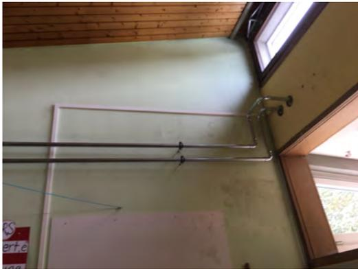
Die restlichen Leitungen wurden sichtbar in den Klassenräumen aufputz verlegt. Dies hat den Vorteil, dass die Wärmeabstrahlung keine Verluste, sondern im Klassenraum als Wärme gewinn auftritt.
