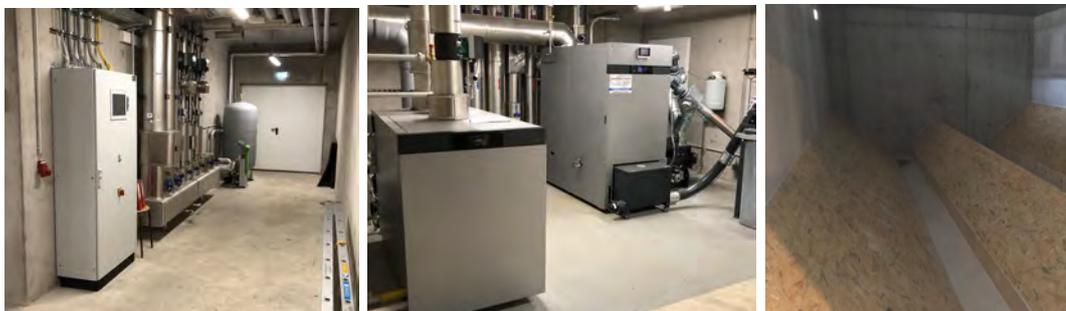
Die Ausführung des Pelletlagers mit ca. 40 Tonnen Lagervolumen ist überdimensioniert, da die Ladung auf dem LKW zur Anlieferung mit 28 Tonnen begrenzt ist. Deshalb reicht das Lagervolumen für zukünftige Pelletlager mit 28 Tonnen deutlich aus.
