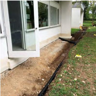
Im Pavillon wurden, wie empfohlen, die Verteilungsleitungen komplett erneuert. Da im vorhandenen Hohlraum unter dem Fußboden eine Reparatur oder Neuverlegung der Leitungen nur mit unverhältnismäßig großem Aufwand möglich war, wurden die Leitungen im Außenbereich (wie Wärmenetzleitungen) verlegt.
