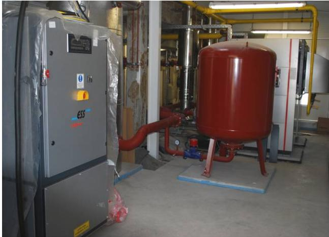
Die Erneuerung der Heizung des Rathauses erfolgte ebenfalls 2010/2011. Die neue Heizzentrale wurde auf dem Dach in einem dafür errichteten kleinen Gebäude untergebracht. Zukünftig heizt die Stadtverwaltung auf zwei Arten, da neben den Heizungskesseln auch ein Blockheizkraftwerk eingebaut wurde. Als weitere Maßnahme wurde im Bürgersaal eine neue Fußbodenheizung eingebaut,
