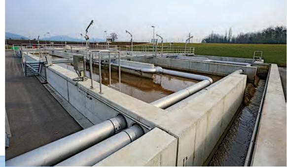
Während der Belüftungsphase wird das Gebläse so geregelt, dass im Belebungsbecken eine vorgewählte Sauerstoffkonzentration eingehalten wird.
