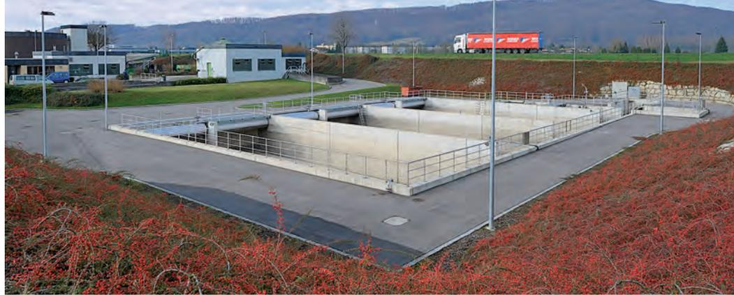
Kammern (1922 m<sup>3</sup>) und einem Durchlaufbecken (1139m<sup>3</sup>) besteht. Ein Vorteil dieser Verbundbeckenlösung liegt darin, dass die Abflüsse von Regenfällen mit
