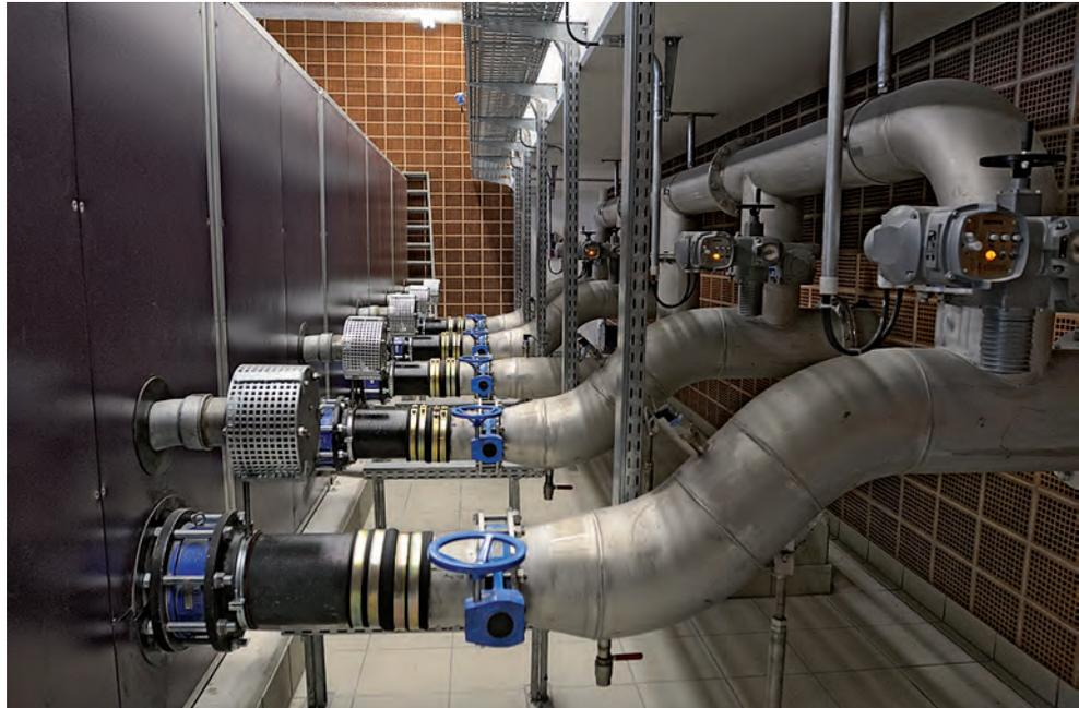
Die Zwischentrennwände an den Enden der Becken wurden abgebrochen, so dass durch den Einsatz von Rührwerken eine entsprechende Strömung erzeugt werden kann. Auch die Belüftungseinrichtungen wurden erneuert. Durch den Um- und Neubau stehen nun zur Nitrifi-
