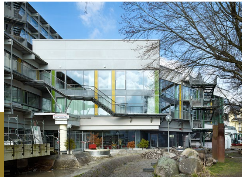
Fluchttreppe vor dem Sitzungssaal 2017
