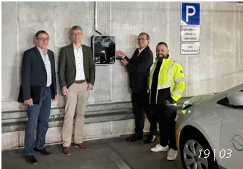
Öffentliche E-Ladesäule in der Rathaustiefgarage
